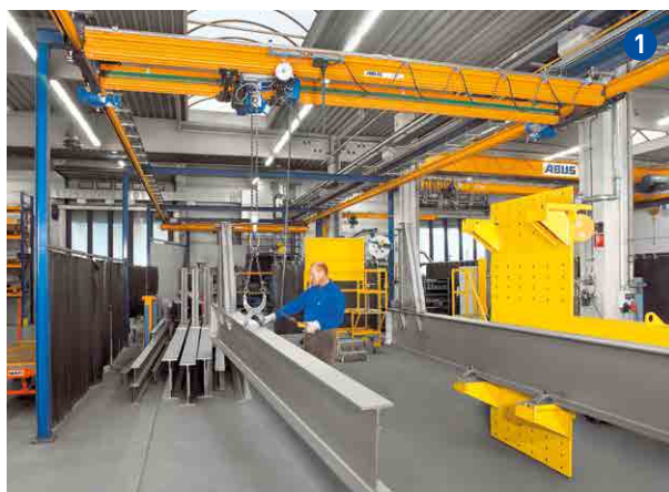
2: Puente grúa birrail ZHB ABUS
