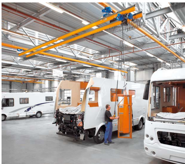
Puente grúa birraíl ZHB ABUS.
