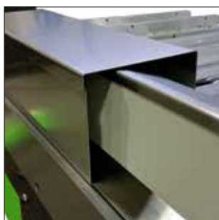
Pliegue el perfil alrededor de la viga.
