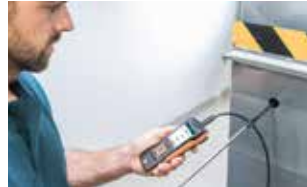
Sistemas de ventilación
