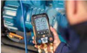
Sistemas de Aire Acondicionado
