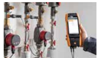
Sistema de Calderas de gas y combustible líquido
