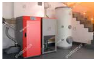
Sistema de Calderas de biomasa y pellets
