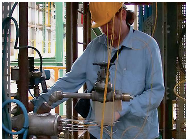
Realizando trabajos de mantenimiento con una cámara de seguridad y diagnóstico
