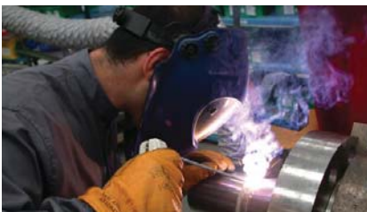
Soldadura con arco eléctrico cualificada
