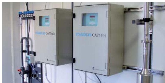
El sistema de medición incluye el acondicionamiento de muestras y la medición del contenido en amonio, fosfatos y nitratos
