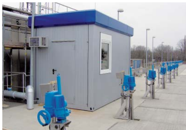
El sistema de medición incluye el acondicionamiento de muestras y la medición del contenido en amonio, fosfatos y nitratos
