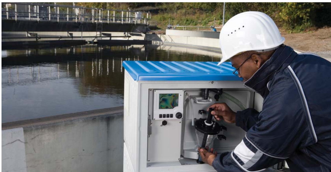
Sencillo de utilizar y fácil de ampliar: El tomador estático de muestras CSF48
