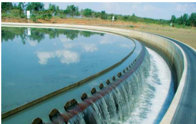
Tratamiento de aguas residuales municipales
