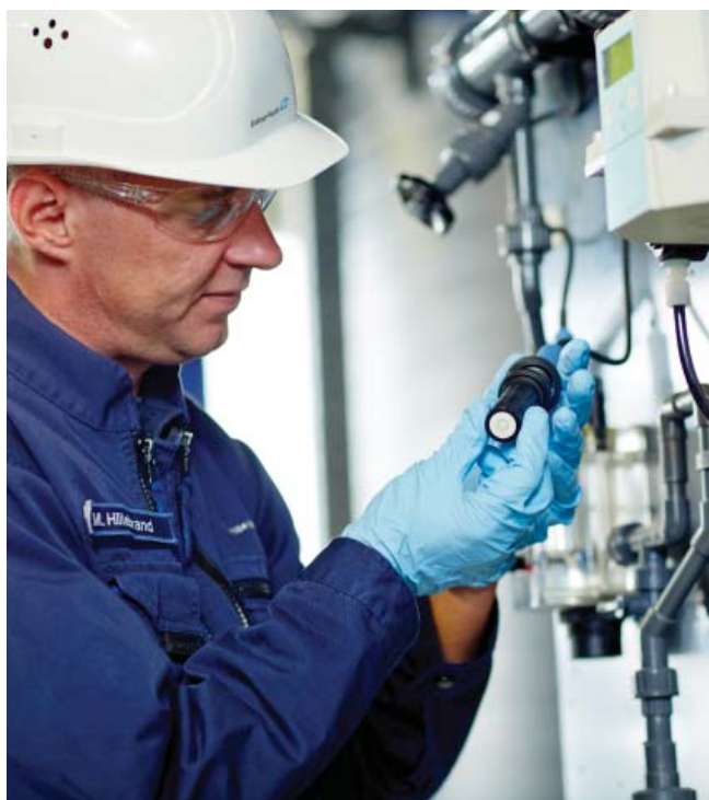
El mantenimiento y la operación de los puntos de medición resultan sencillos con nuestras soluciones de panel
