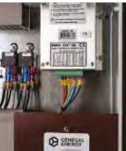
Mantenedor de nivel de batería de motor desde red externa
