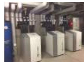
Esquema de 3 bombas en cascada 5-22, con una configuración geotérmica, alcanzando una potencia máxima de 66 kW y modulando el conjunto hasta un 90%.
