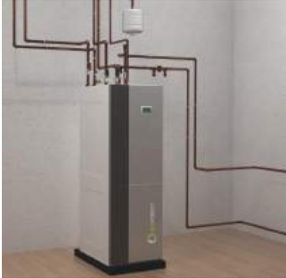
Esquema de mayor implementación por su sencillez y el reducido espacio que requiere. Con esta configuración se puede suministrar dependiendo del módulo, calefacción, frío pasivo, frío activo y agua caliente sanitaria. Solamente serían necesarias las siguientes sondas: sonda exterior, sonda de ACS y señal de activación de clima.
