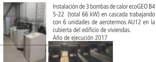
Instalación de 3 bombas de calor ecoGEO B4 5-22 (total 66 kW) en cascada trabajando con 6 unidades de aerotermos AU12 en la cubierta del edificio de viviendas. Año de ejecución 2017
