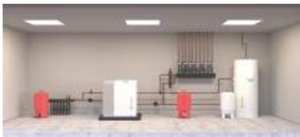
Esquema que cubre grandes demandas térmicas simplificando mucho tanto la parte hidráulica como la parte de gestión. Con el módulo 1 se cubre la demanda de calefacción, calentamiento vaso de piscina y agua caliente sanitaria. Serían necesarias las siguientes sondas: sonda exterior, sonda de ACS y señal de activación de calefacción.
