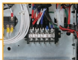
Unidad exterior terminales de alimentación trifásica
