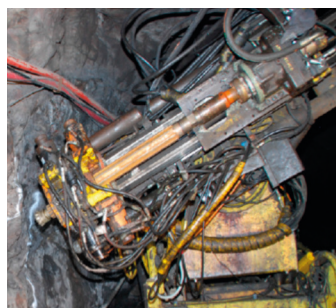
Wassara en la aplicación de pozos de servicios públicos
