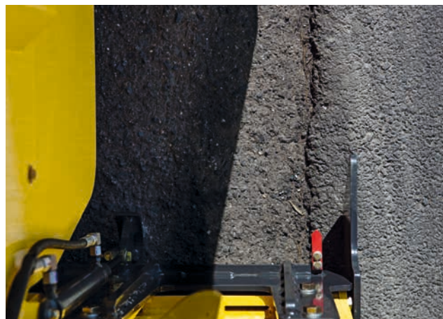
La indicación del borde de fresado que tiene el pisador permite una colocación precisa.
