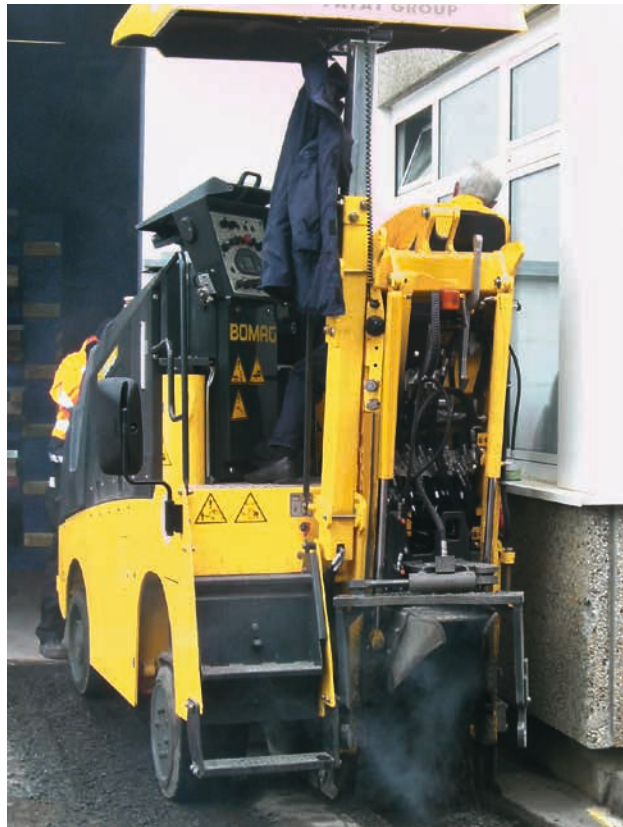
¿Desea avanzar con precisión hasta el mismo muro del edificio? No hay problema.
