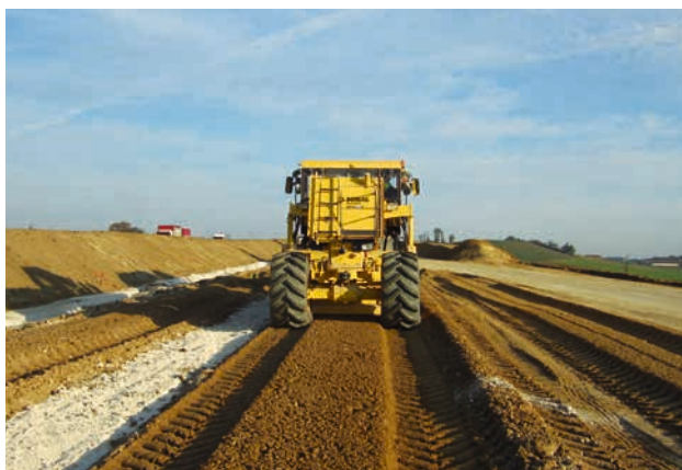
Calidad óptima de mezclado y un espesor de capa uniforme gracias a la tecnología BOMAG FLEXMIX.
