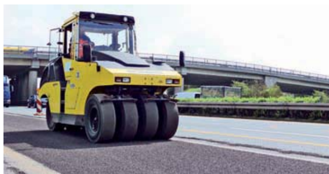
Fig. 62 Compactación previa, rodillo de neumáticos BW 24 RH
