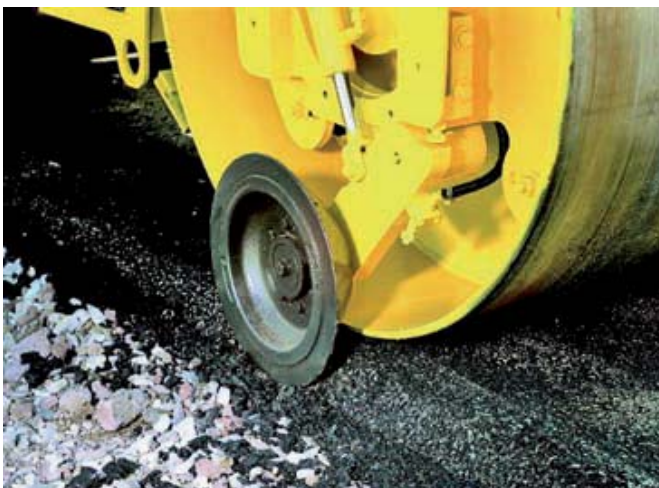
Fig. 39 El rodillo de compresión vuelve a crear un borde de capa liso y con ángulo.
