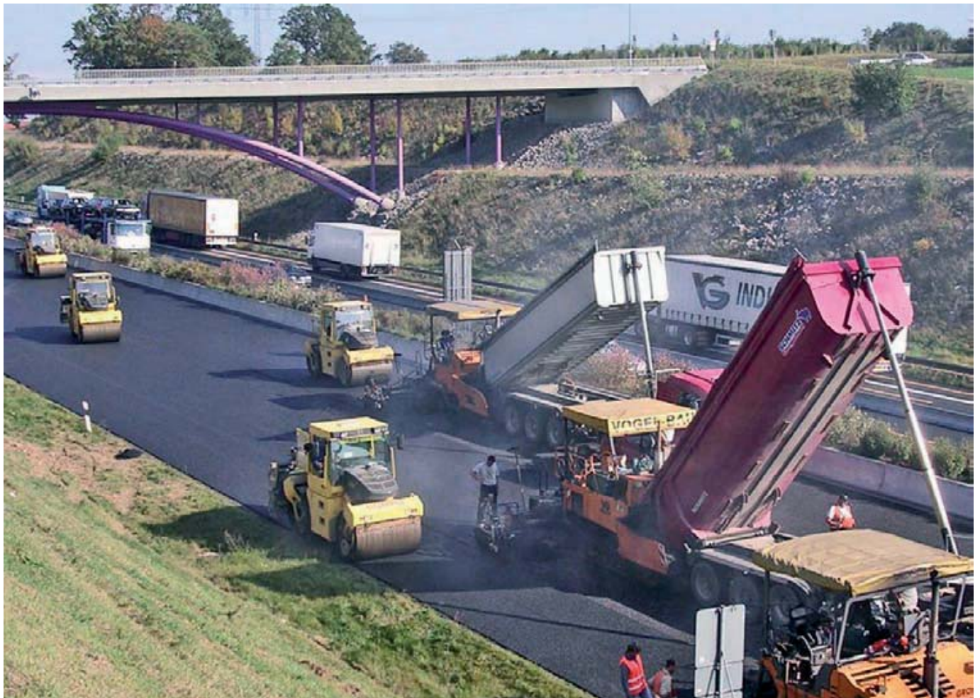
Fig. 47 Aplicar y compactar una capa de rodadura de asfalto con tres extendedoras y cinco rodillos de vibración (10t). Ancho de aplicación > 10m; rendimiento por jornada > 3.000t.
