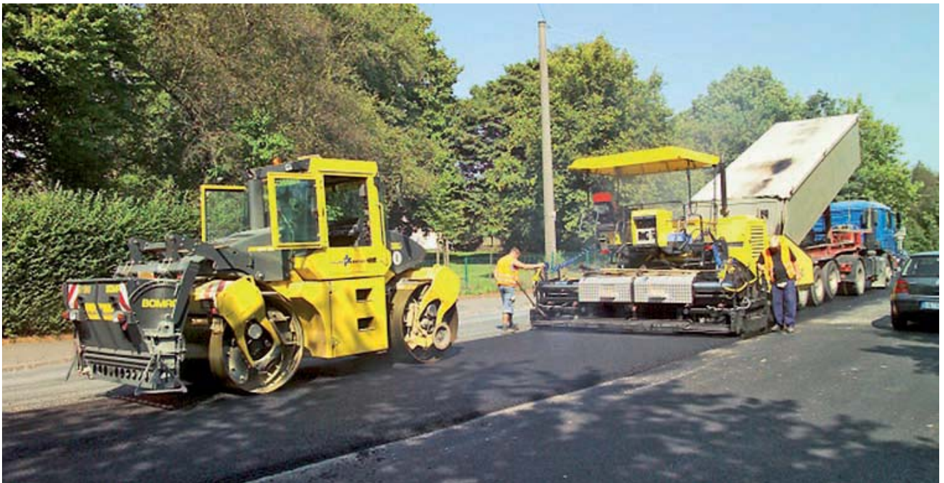
Fig. 7 Extender y compactar con la extendedora BOMAG BF 600 P y el rodillo pivotante BOMAG BW 174 AD-AM
