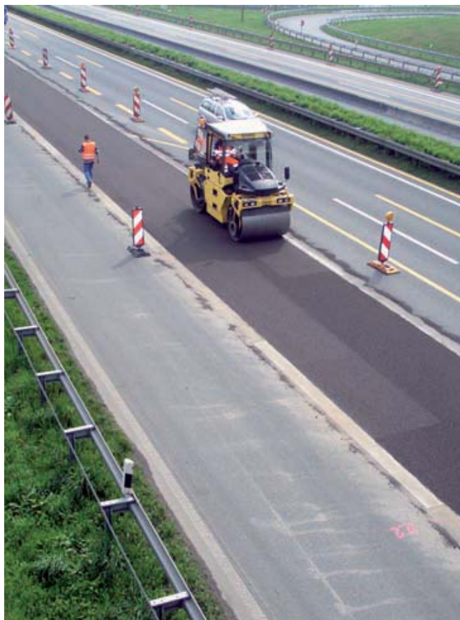
Fig. 70 Compactar una junta longitudinal
