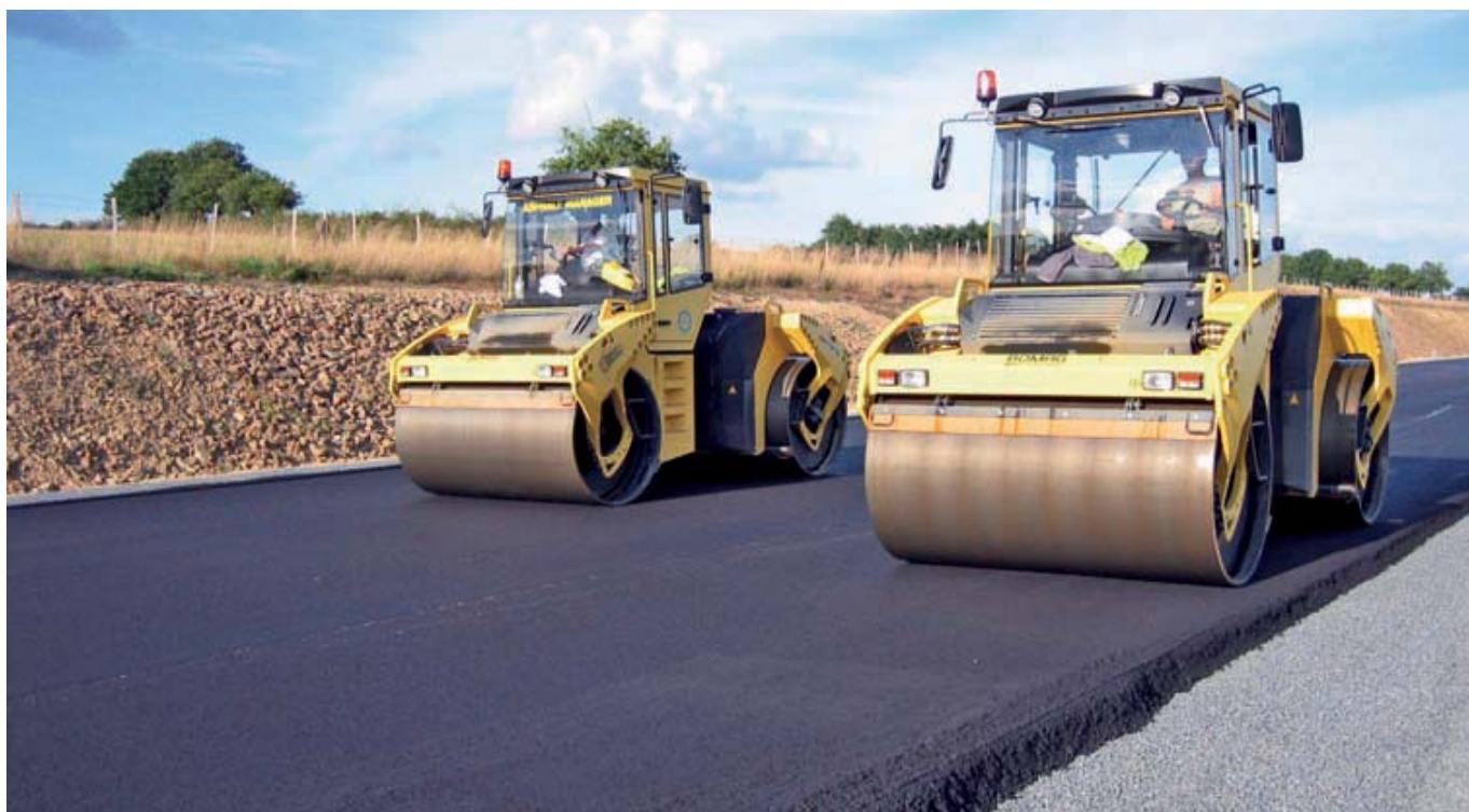
Fig. 51 BW 203 AD en una capa base de asfalto de 16 cm con un rendimiento de compactación de 250 t/h cada una
