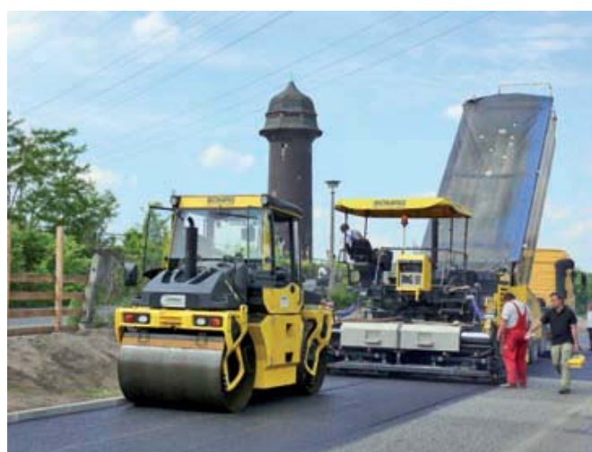
Fig. 58 BW 154 AP compactando una capa de rodadura con reborde
