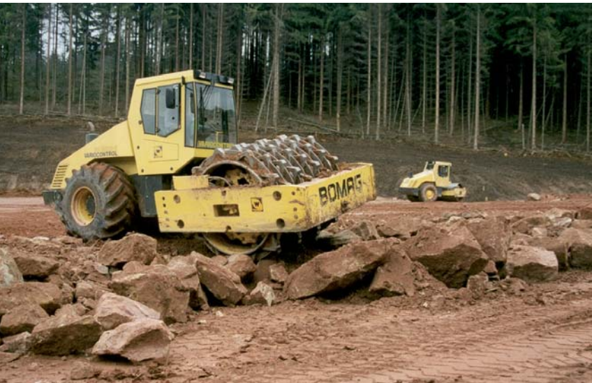
Figura 1: Rodillo autopropulsado BOMAG de 26 t con rodillo triturador de rocas en servicio
