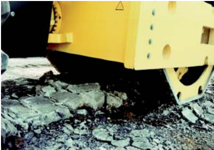
Figura 8: Destrucción de firme de hormigón con un rodillo autopropulsado DI
