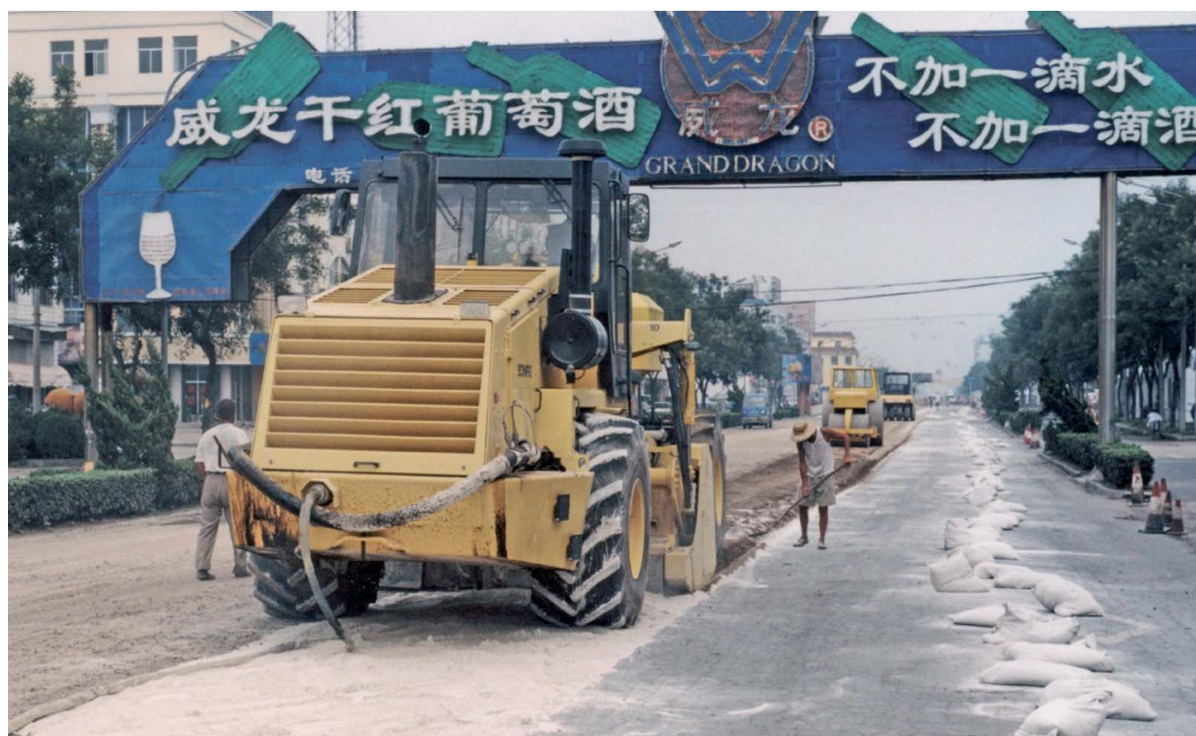
Fig. 1: Reciclaje de carretera en Yantai, China
