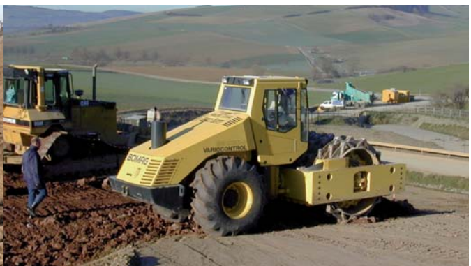
Figura 4: Rodillo autopropulsado RC durante la trituración final y compactación en el lugar de colocación
