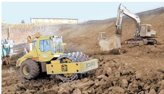
Figura 3: Rodillo autopropulsado RC durante la trituración primaria en el lugar de explotación
