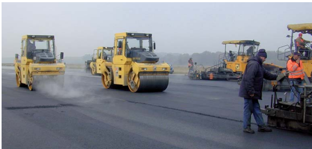
Fig. 4: Renovación de la capa de cobertura, aeropuerto Münster/Osnabrück
