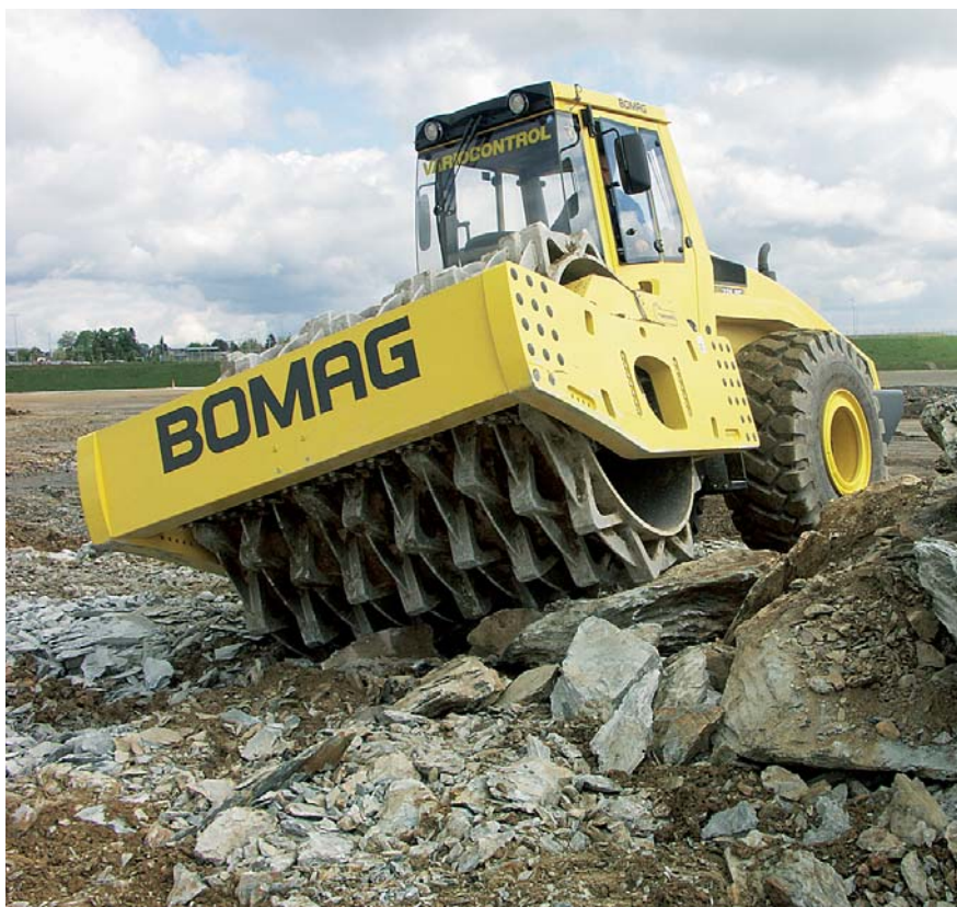
Figura 5: Rodillo autopropulsado RC rompiendo rocas
