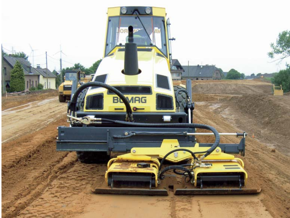
Figura 2: Compactación de un talud con desplazamiento lateral de las bandejas
