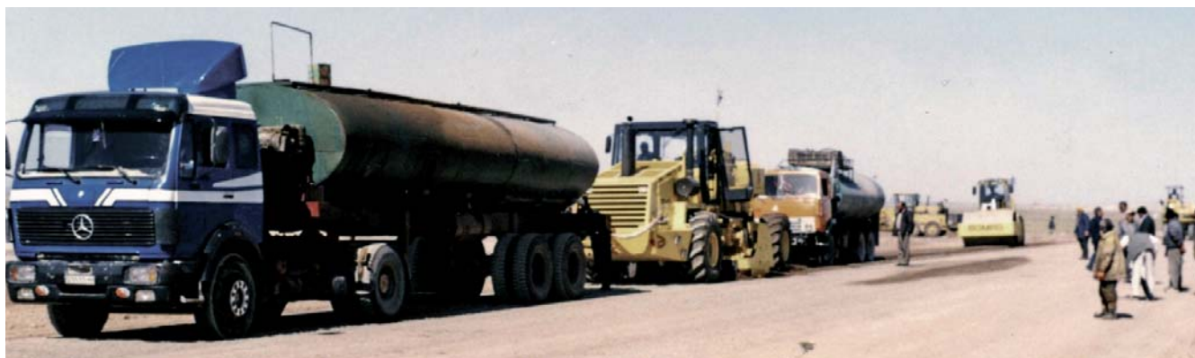
Fig. 6: Construcción de nuevas carreteras en Afganistán
