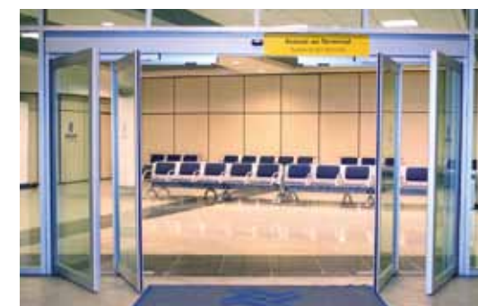
Puerta antipánico con hojas enmarcadas. Sector aeropuertos.
