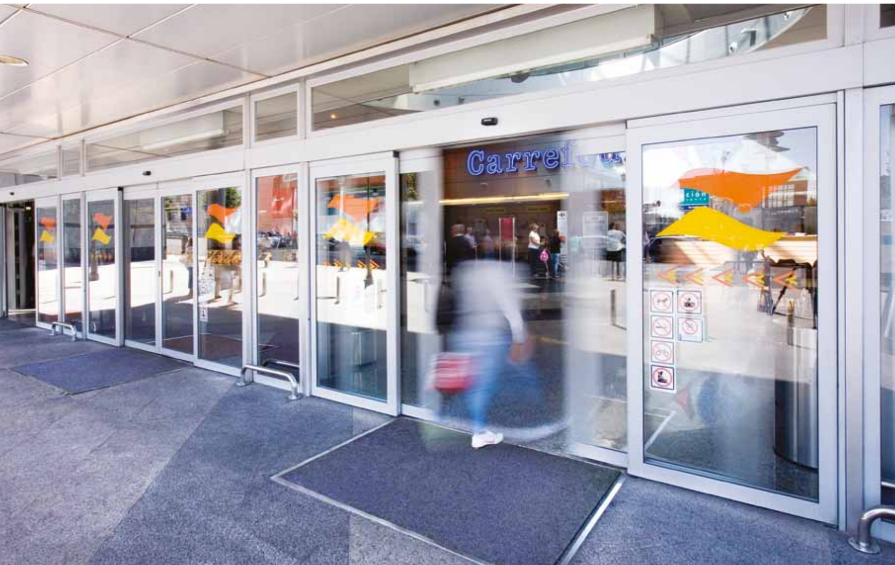
Puerta antipánico con hojas sin perfilera vertical. Edificio oficinas.
