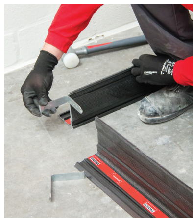
03 Coloque las uniones angulares
