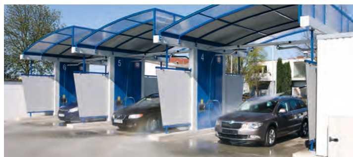
Cubierta en diente de sierra
