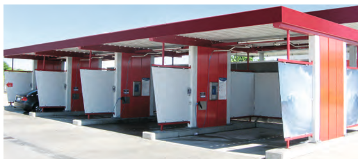
Cubierta plana con estructura de azotea
