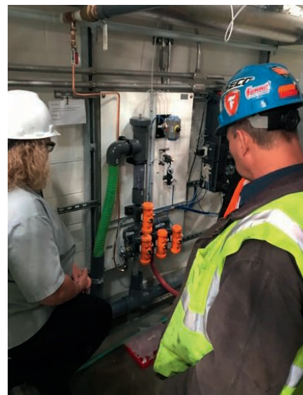
Equipo de arranque y vista del panel de filtración de alta resistencia EZ9130 para su uso con digestores anaerobios
