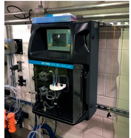
Vista del analizador EZ7250: medición en continuo y de una sola vez de AGV, alcalinidad, bicarbonato y pH
