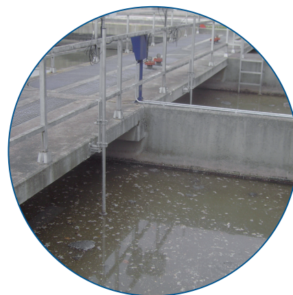
Fig. 5: Fácil instalación gracias a sistemas de fijación variables. El punto de medida óptimo depende del diseño de la tolva y debe determinarse llevando a cabo medidas comparativas.
