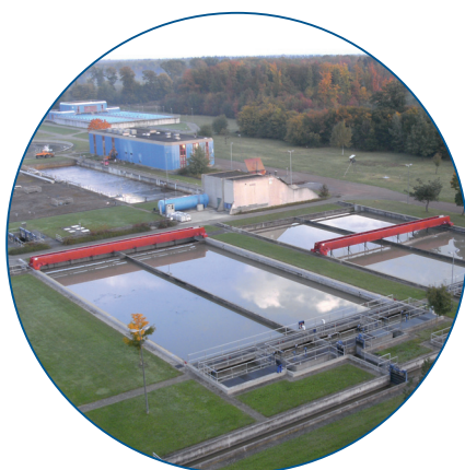
Fig. 1: Vínculo entre el tratamiento biológico y el tratamiento de fangos: los decantadores primarios.
