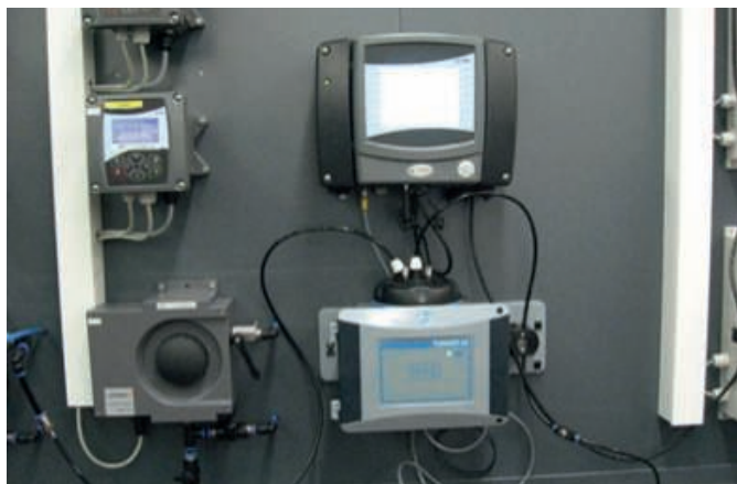
Figura 3: TU5400 con instalación de SC1000 en una planta de tratamiento de agua potable de Alemania
