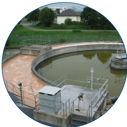
Fig. 1: Canal de oxidación con tanque de sedimentación final central
