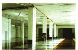
Suelos de hormigón sellados y recubiertos con CORR-UNIT 65 no producen polvo, son resistentes al ataque por abarasión, combustibles, grasas y aceites.
