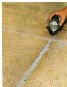
"flex-unit" como material de colada para el sellaje de juntas de dilatación y el relleno de grietas en hormigón y obra.
