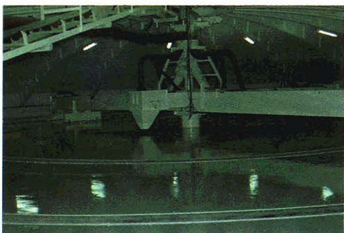
Recubrimiento UNITEROX del suelo de un silo de azúcar, resistente a la abrasión, higiénico, aislante y químicamente neutro.
