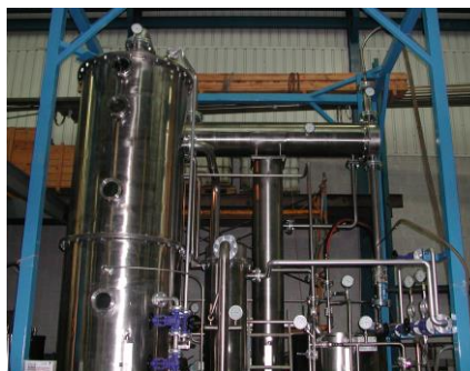
Unidad de Deshidratación
