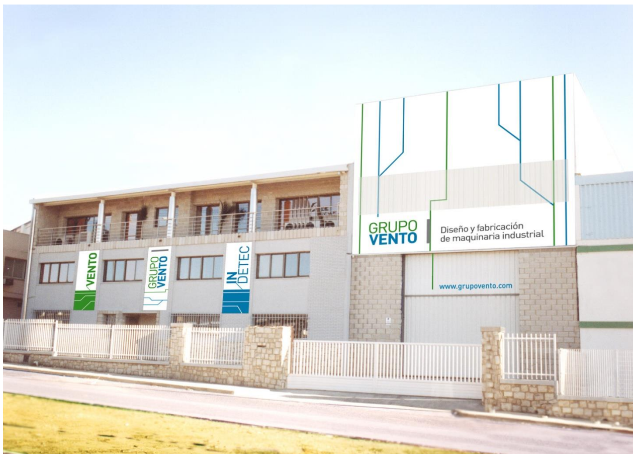
Instalaciones del GRUPO VENTO en Paterna (Valencia)
