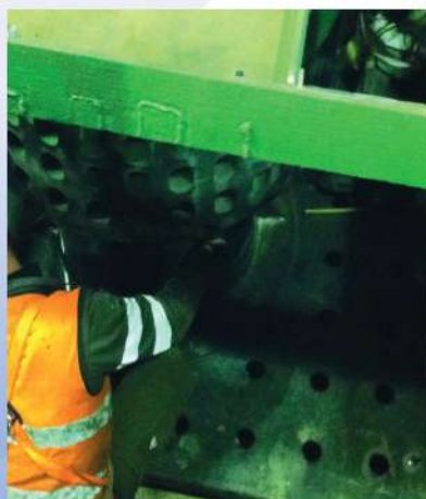
Suelo Celda Flotación
