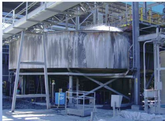
Forro Tanque Estériles
