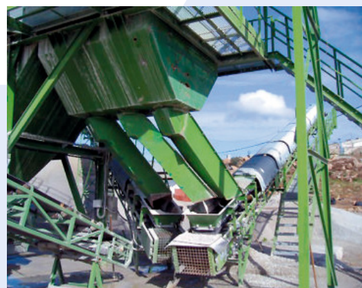
INSTALACIÓN DE MAQUINARIA EN CANERA DE ÁRIDOS
