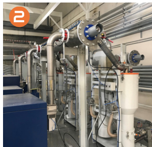
2 Anillo central de vacío (ahorro energético).
