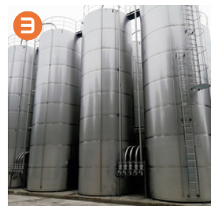
3 Silos Inoxidable / Aluminio Capacidad: de 30 a 250 m 3
