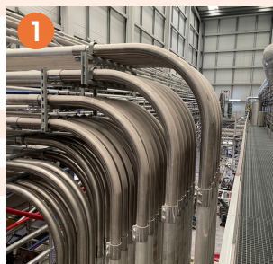
1 Líneas de material y accesorios Tubo: Alu. / Inox. / Flexible / FU / PVC Curvas: Inox. / anti-abrasión.
