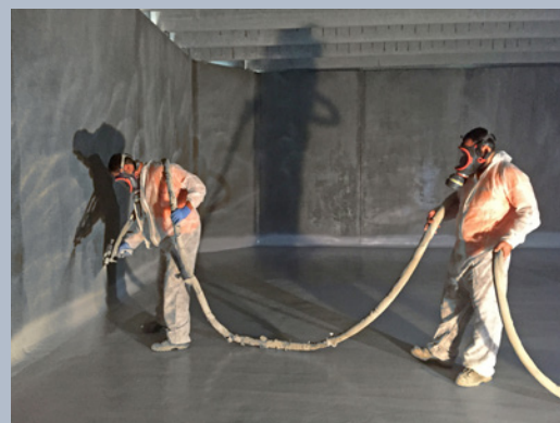
Impermeabilización por pulverización de un depósito de agua potable de obra civil.
